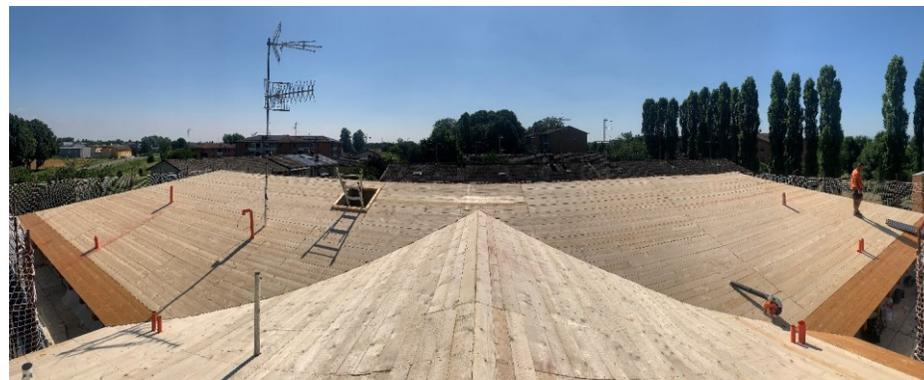
Telo impermeabile e traspirante a protezione della struttura lignea
